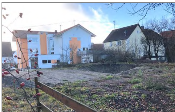
Bestand ehem. Ökonomiegebäude – nach Freilegung
