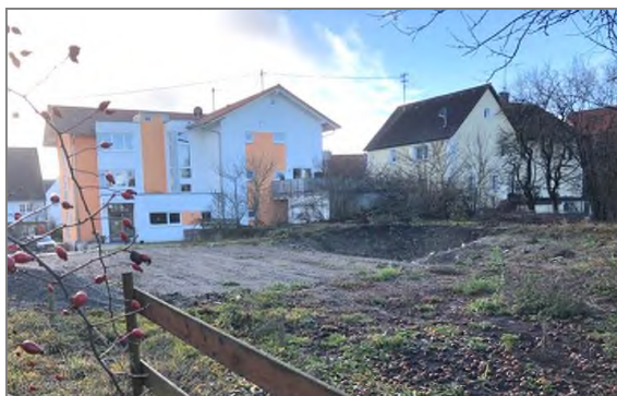
Bestand ehem. Ökonomiegebäude – nach Freilegung
