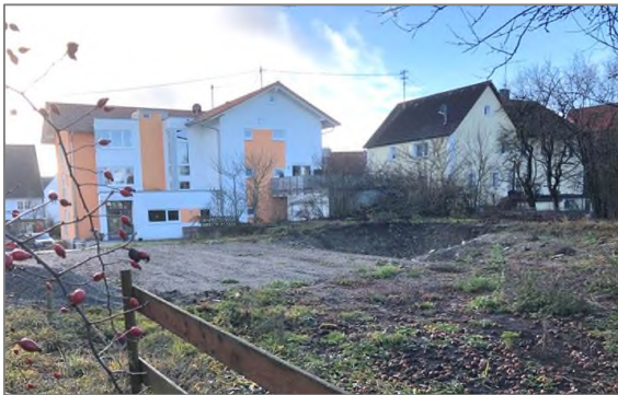
Bestand ehem. Ökonomiegebäude – nach Freilegung
